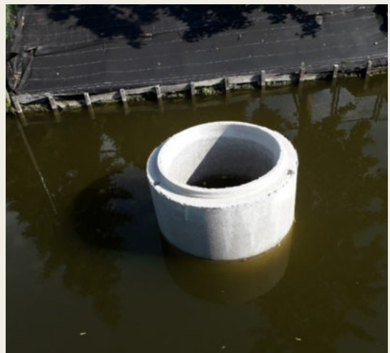
Fig 112. De betonnen buis bood de beheerwerkers de kans om na te gaan of het beheer werkte zonder de afdekking van het hele behandelde gebied weg te halen. Foto: Provincie Oost-Vlaanderen dienst Integraal Waterbeleid
