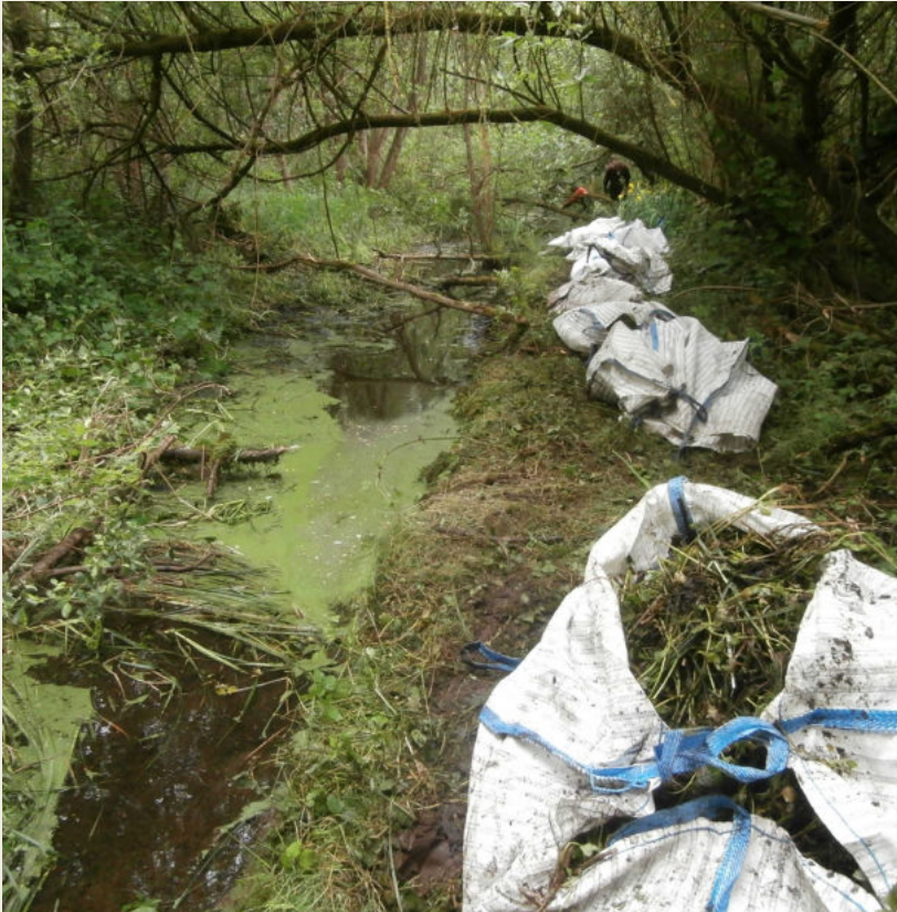
Fig 126. Het geogoste plantenmateriaal werd verzameld in big bags voor het werd afgevoerd naar een stortplaats. Foto: Province du Brabant Wallon
