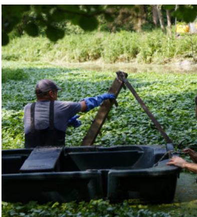
Fig 20. Een grote hark wordt voortgetrokken door een lier op de oever en helpt de beheerwerkers om een grote hoeveelheid plantenmateriaal te verwijderen. Foto: Adrien Latli.
